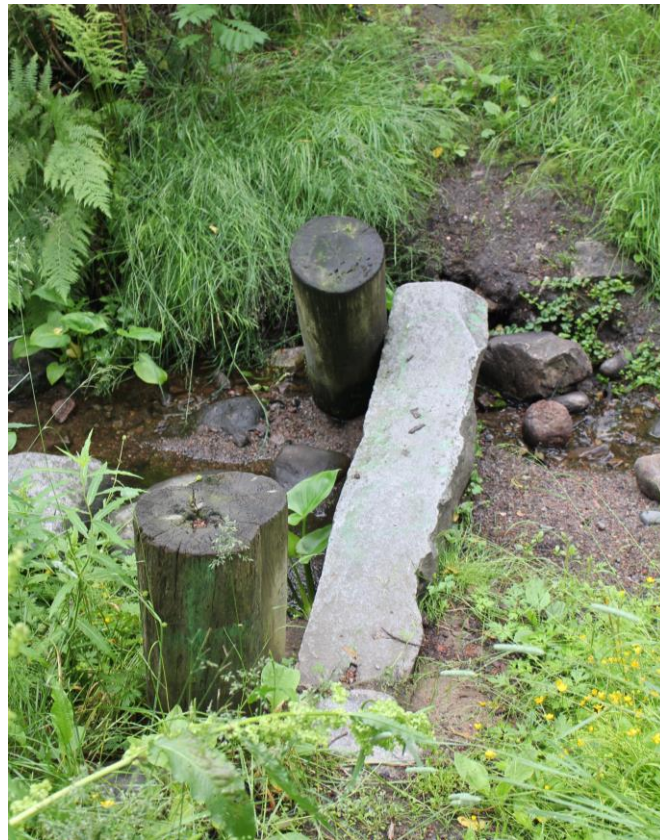
Kuva 15. Hakalanpuiston puron vettä viivyttävä patorakenne. (Kuva: Laura Kotilainen 2015)
